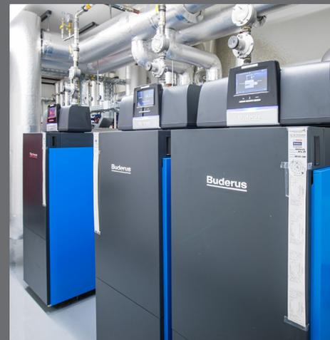
Kaskade aus drei Logano plus KB372 mit Regelgerät Logamatic 5000
