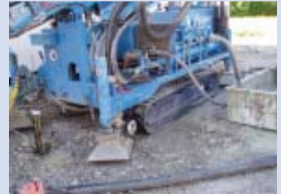
Nach erfolgreicher Tiefenbohrung kann die horizontale Anbindung beginnen.
