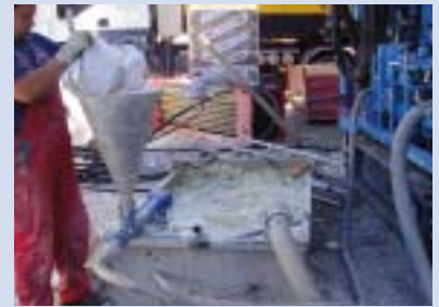
Nach Einbringen der Erdsonde wird das Bohrloch hinterfüllt.
