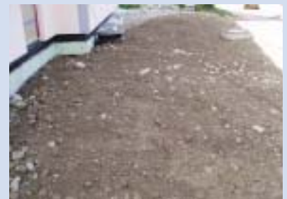
Nach der horizontalen Anbindung und Grobplanie sind die Außenarbeiten abgeschlossen.
